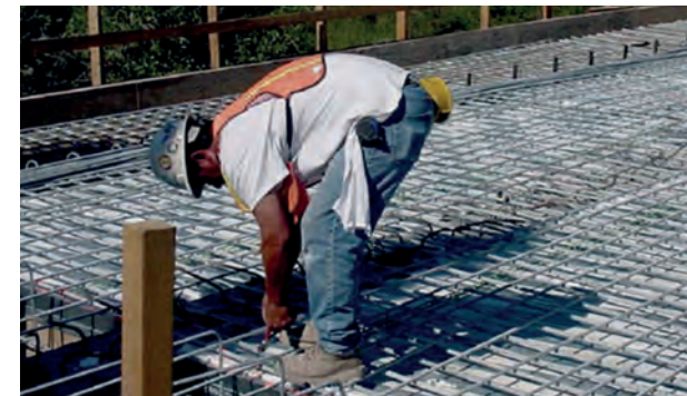
Bild 10-15. Varmförzinkad armering i bro.
