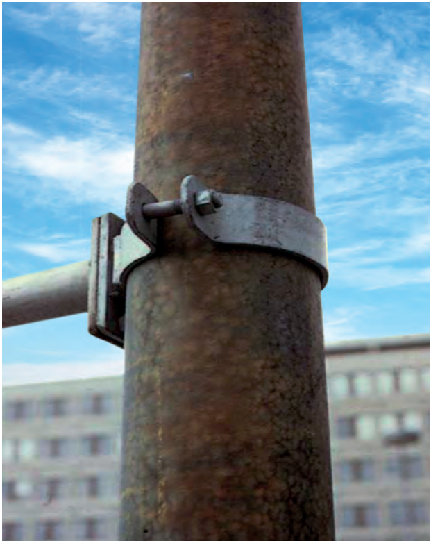
Bild 10-2. Rödbrun missfärgning.
