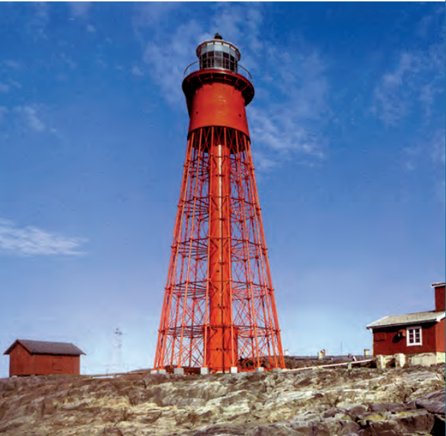
Bild 11-1. Fyren Pater Noster är en av Sveriges första duplexbehandlade konstruktioner. Den varmförzinkades 1868 och målades därefter.
