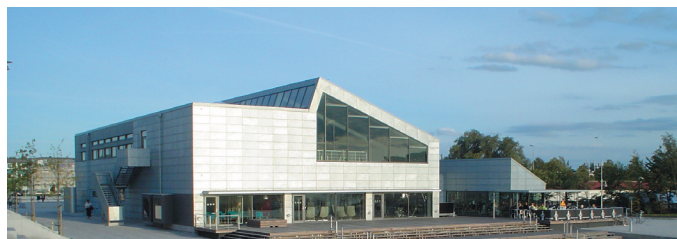
Lomma Bibliotek i södra Sverige är en av de byggnader med varmförzinkad fasad som fått mycket publicitet.
