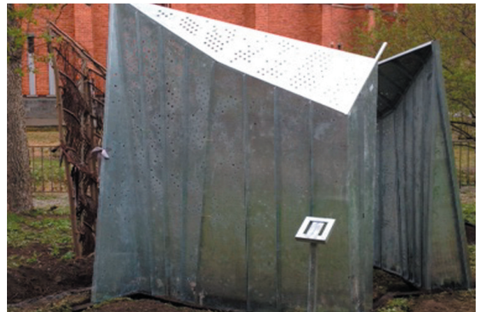
Sinkkilevystä rakennettu Gläntan-paviljonki sijaitsee Norra Djurgårdsstadenin projektitoimiston edessä. Paviljongin perusta on kuumasinkitty.
