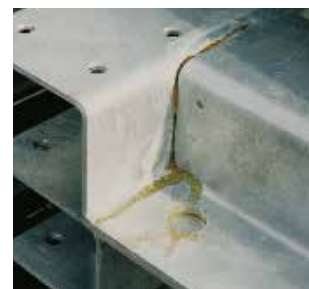
Syrelommer, hvor syren og jernsaltene har ætset hul på zinklaget med misfarvninger til følge.
