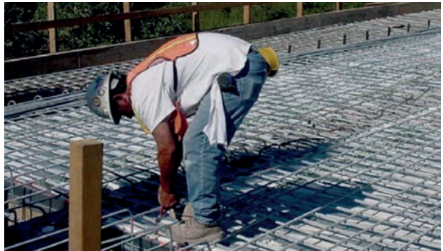
Billede 10-15. Varmforzinket armering i en bro.
