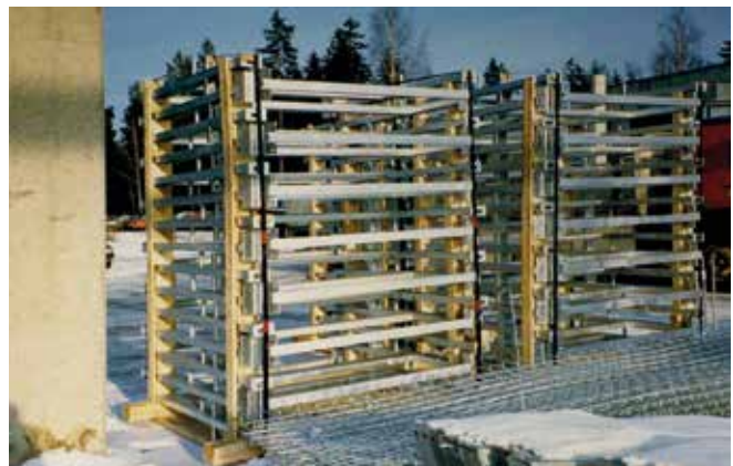
Kuva 3. Sinkitty teräs on säilytettävä kaltevasti ja käännettynä niin, että vältetään veden kertyminen sen pinnalle. Rakoja ei saa muodostua, ja kaikkien pintojen on tuuletuttava.
