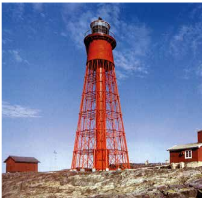
Billede 11-1. Fyret Pater Noster er en af Sveriges første duplexbehandlede konstruktioner. Den blev varmforzinket i 1868 og derefter malet.
