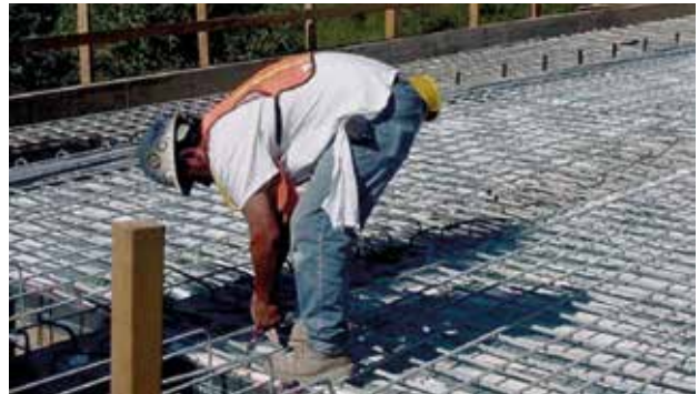
Billede 10-15. Varmforzinket armering i en bro.
