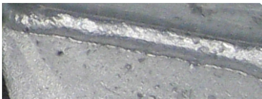
Kuva 25. Yhtenäinen hitsisauma kuumasinkityksen jälkeen.
