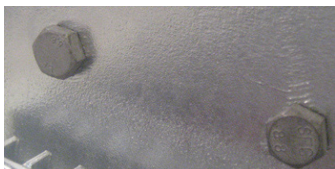
Kuvat 27 ja 28. Kuumasinkityt pulttiliitokset.
