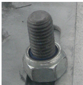
Bild 27 och 28. Varmförzinkade bultförband.
