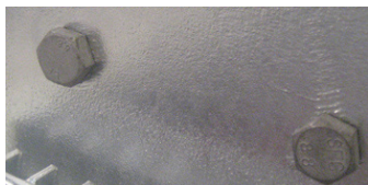
Bild 27 och 28. Varmförzinkade bultförband.
