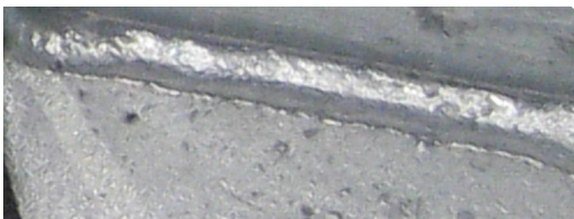
Bild 25. Utseendet hos en sammanhängande svets efter varmförzinkning.
