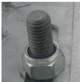
Billede 27 og 28. Varmforzinkede bolteforbindelser.
