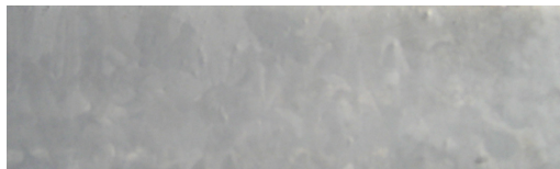
Billede 5. Efter nogen tids brug, er overfladen påvirket af vejr og vind og blevet lidt mere mat i udseendet.
