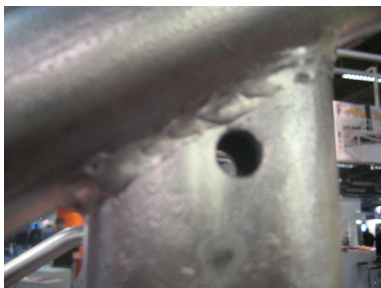
Billede 18. Eksempel på hul tæt på svejsningen. Hullet er boret igennem begge sider af profilet. Se også figur 4.
