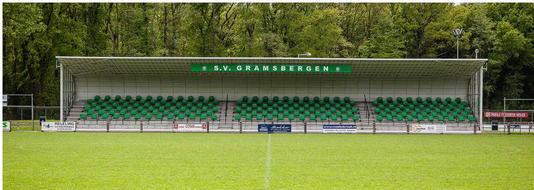
Till vänster Den rekonstruerade läktaren på SV Gramsbergen är redo för ytterligare en livscykel tack vare sitt varmförzinkade stål som totalt kan bli 100 år
